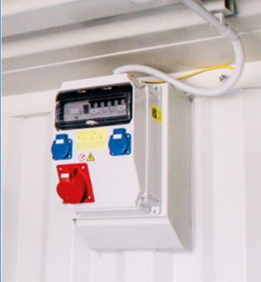
Verteilerkasten mit integrierten Steckdosen
