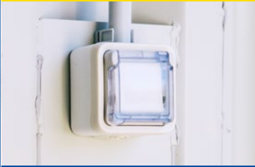
Verteilerkasten mit integrierten Steckdosen
